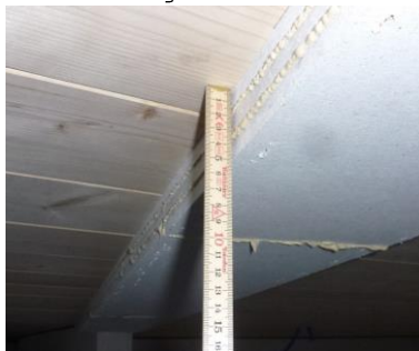
Bild 1: Ausführungskontrolle der Brandschutzplattenverkleidung
